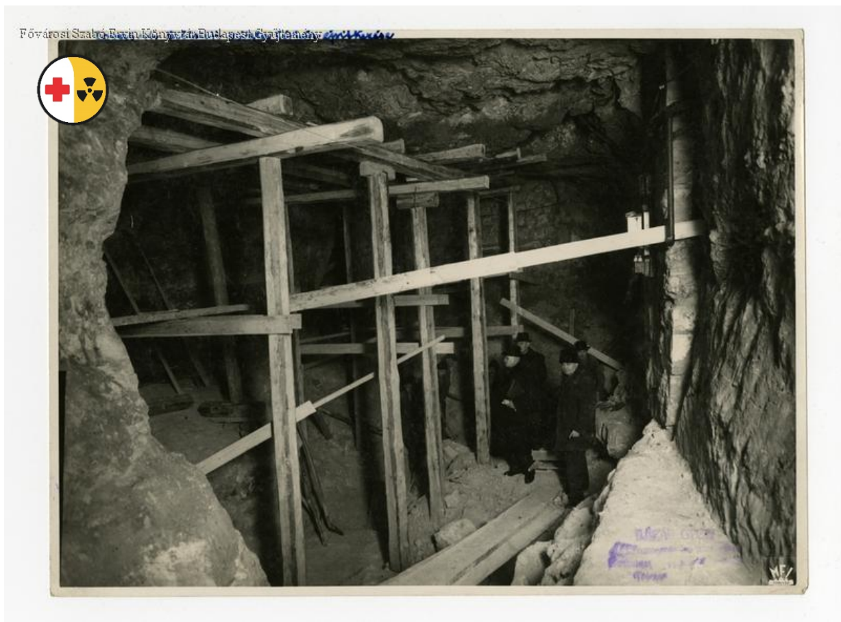
Képek az építkezésről: a barlangrész megerősítése, szivattyúzás, kórteremépítés.
